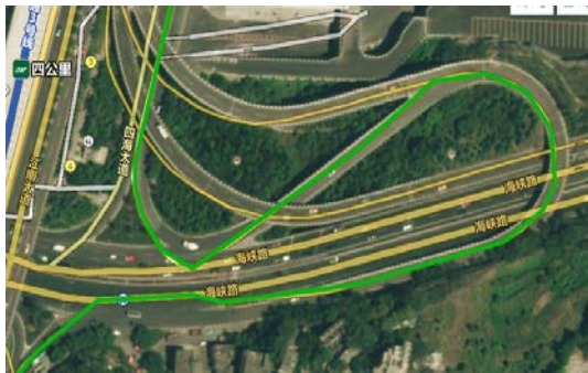
图3. 四公里立交安全隐患点
