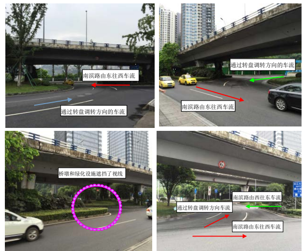
图4. 南滨路黄葛渡立交桥转盘处的安全隐患
